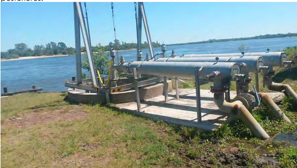
*Figura 1: toma de agua en el Río Negro, en el establecimiento Santa María, donde se puede apreciar la presencia de tres bombas independientes, que están conectadas vía inalámbrica con sendos pivots de riego.*
